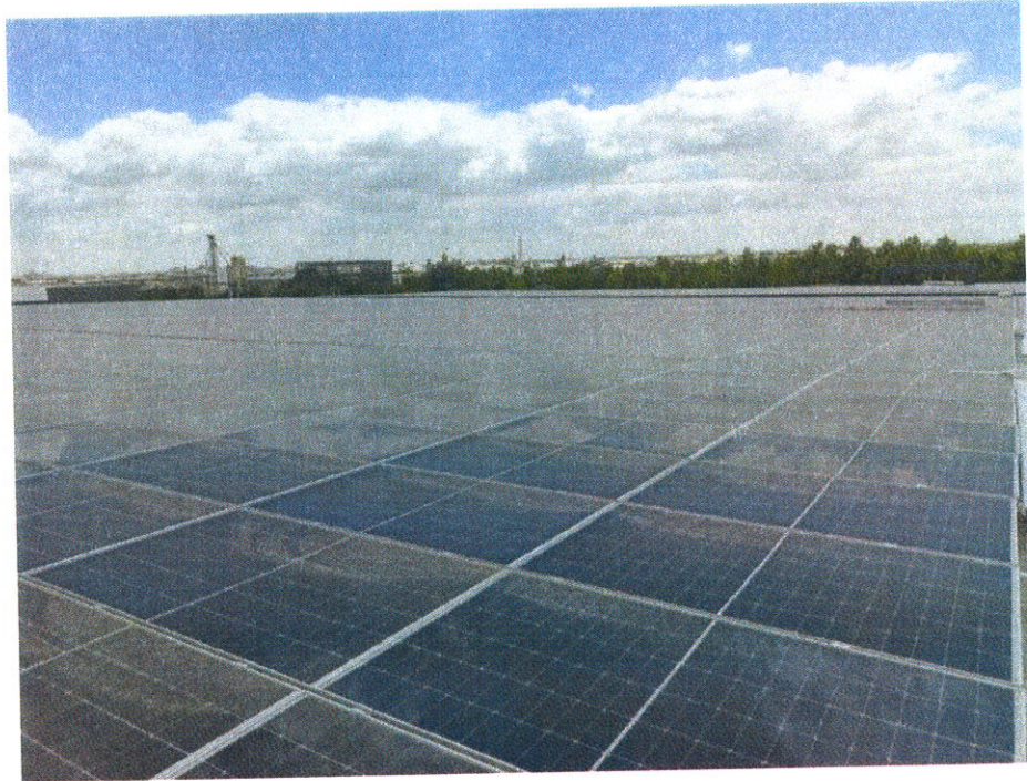
Şekil 16: Panel Yerleşimi Yapılması
