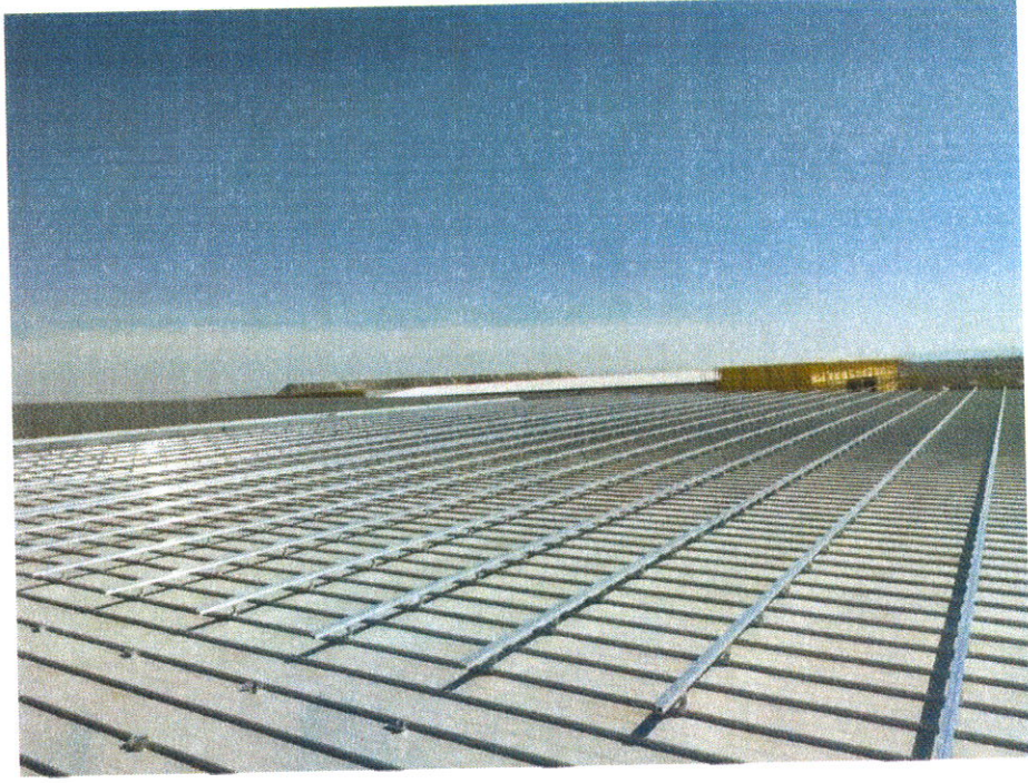
Şekil 15: Çatı Alt Yapısı
