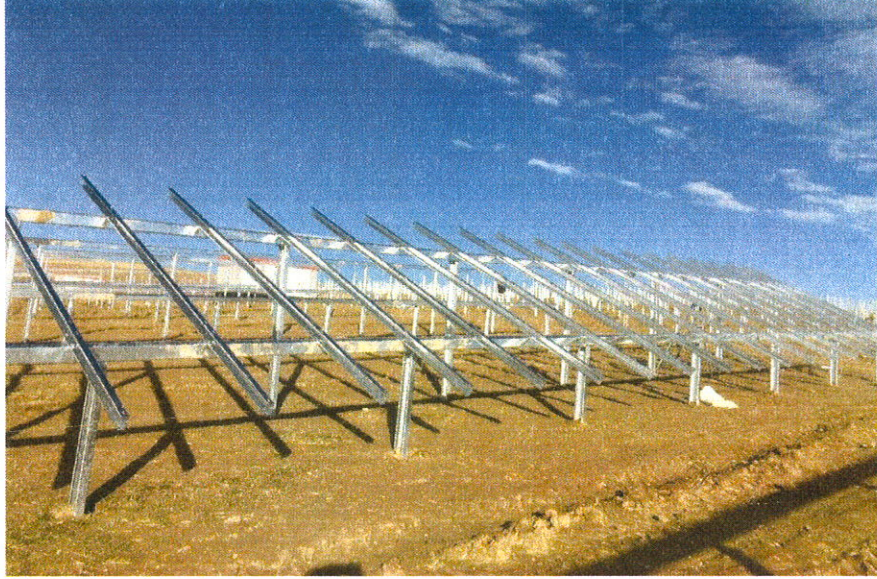
Şekil 8: Alt Yapı Çalışmaları
